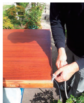
④コーキング、タッカーをカッターやヘラで除去します。
