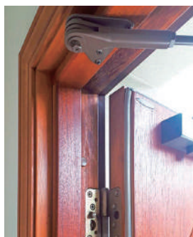
①ドアパネルを枠から外します。ドアパネルを持ち上げるとヒンジが抜けます。
