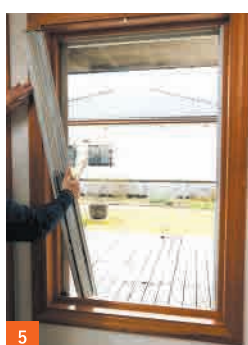
5 左右にあるフレームを外して中のバランサーを交換します。
