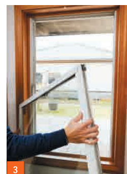
3 同様の手順で上部障子を外します。
