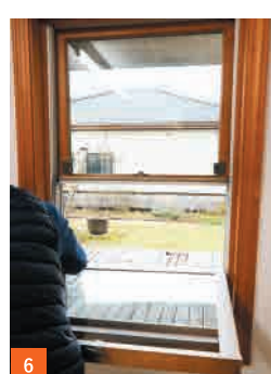
6 上部障子→下部障子の順に再度取付をして完了。
