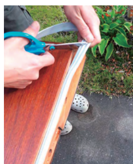
⑧溝にパッキンを押し込みながら取り付けをしていきます。
