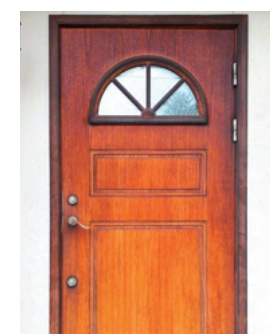
⑩接着具合を確認して、ドアパネルを取り付けて作業完了です。
