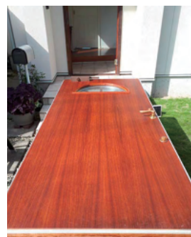
③既存のパッキンを外します。
