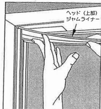
6 上部ジャムライナーを外します。木製押し縁を施してがあれば、それも外します。室内側の仕上げを傷つけないよう外側より外します。
