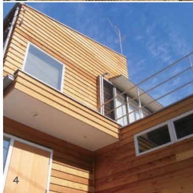
1 チャンネルサイディング施工例 2・3・4 ベベルサイディング施工例
